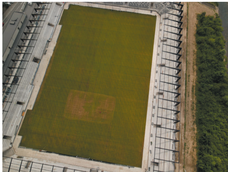
Budowa stadionu Sandecji Nowy Sącz - stan realizacji na czerwiec 2023.
